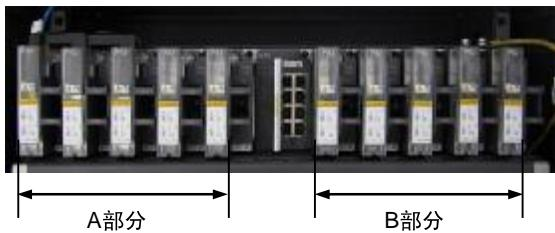
当不使用短接铜排时，采用5+5供电方式，每路额定输入电流为63A。
